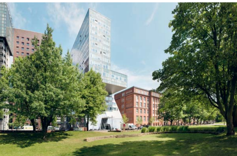
Großes Bauvorhaben: Blick auf das „Elektrohochhaus“ am Berliner Tor 7 (oben). Lohmühlenpark als erster Schritt großer Veränderungen auf dem Campus: Blick auf das Hauptgebäude am Berliner Tor 5 (unten).
